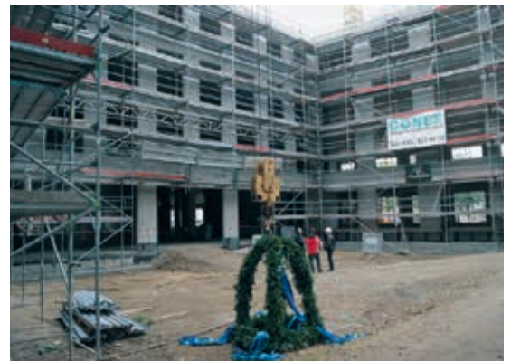
Der Rohbau des neuen Gebäudes der LÄKB und der KVBB ist fertig gestellt. In feierlichem Rahmen wurde Ende September Richtfest begangen.
